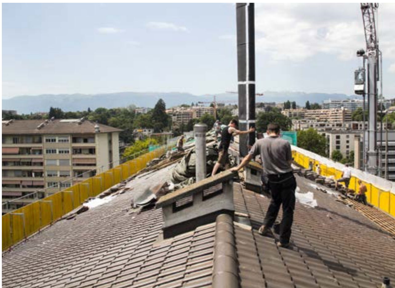
Pose de conduites solaires de 30 m de longueur
