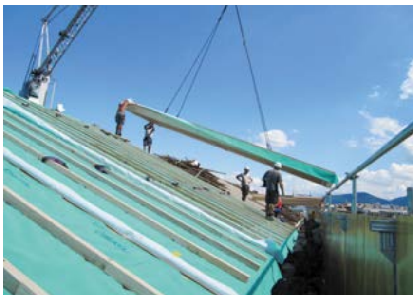
Pose d'un élément préfabriqué de toiture
